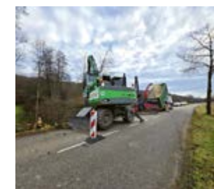
Entretien de cours d'eau à Turckheim avec abattage d'arbres et sortie de souches du cours d'eau.
