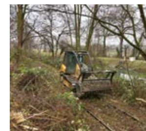
Réouverture d'une digue à Colmar avant réfection de celle-ci et création d'une piste cyclable
