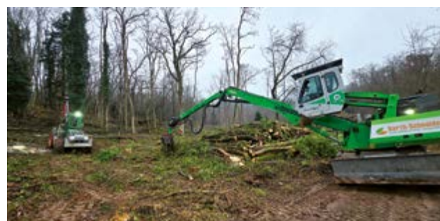
Création d'une zone tampon prairie à Ribeauvillé
